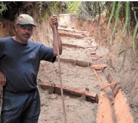
Um den Hohlweg begehbar zu machen, musste zunächst eine Entwässerung her
