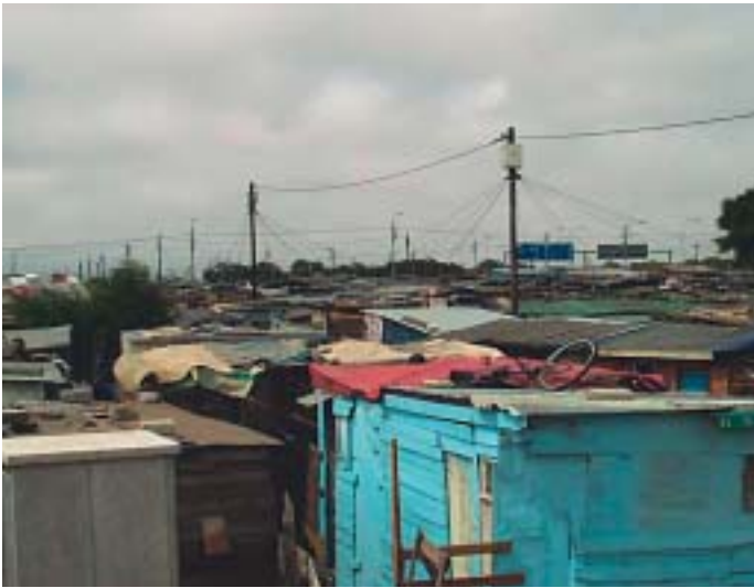
Eine Wellblechhüttensiedlung, die sich zwischen dem Township Langa und der Autobahn gebildet hat
