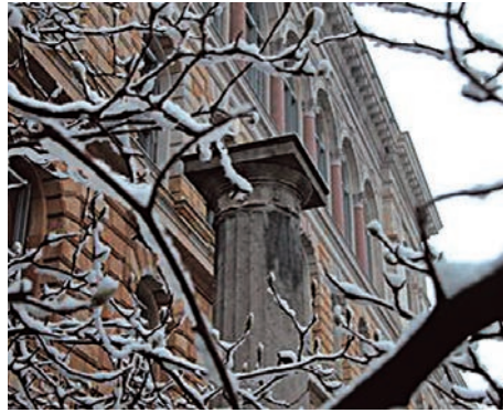
Fassade aus Schlesischem Sandstein
